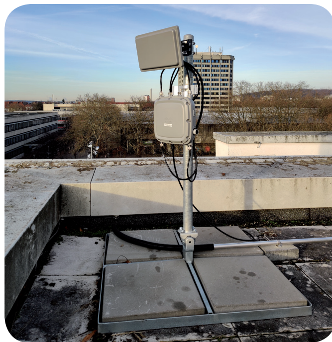
4_Fertig angebrachter Accesspoint inklusive externer Antenne auf dem Dach der SUB
